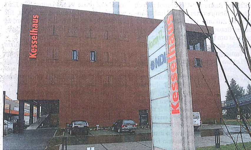
Das Firmenschild vor dem Kesselhaus kann ab Mai mit einem neuen Namen versehen werden. Das SGS-Institut Fresenius kommt nach Radolfzell. BILD: JARAUSCH
